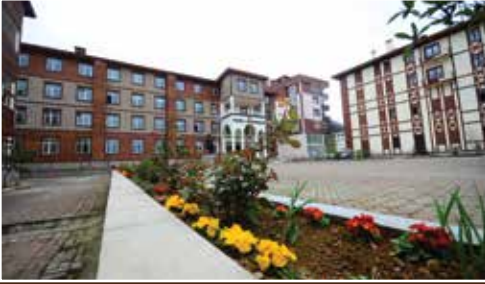
Fındıklı Hükümet Konağı Onarımı
