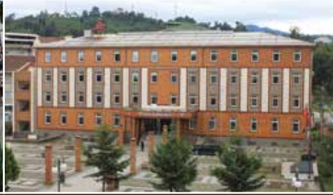
Ardeşen Hükümet Konağı Onarımı
