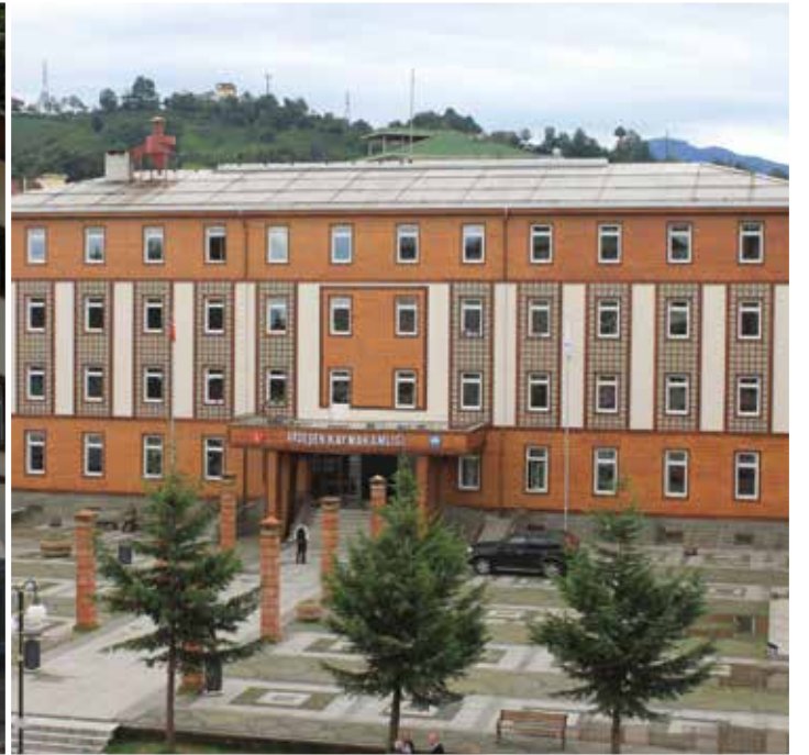
Ardeşen Hükümet Konağı dış cephe uygulaması
