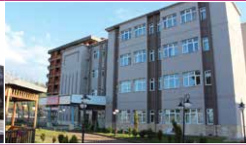
Çayeli Rehabilitasyon Merkezi Onarımı
