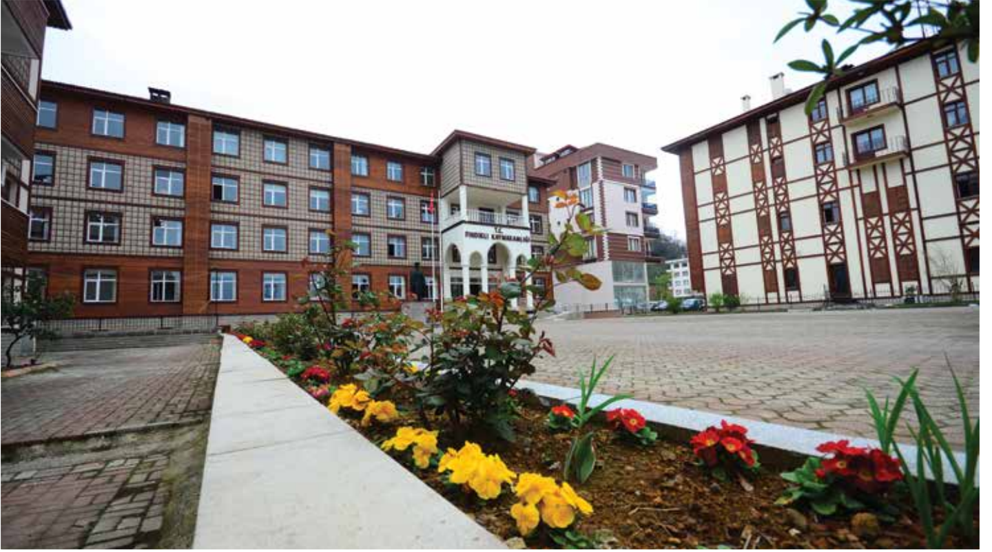
Fındıklı Hükümet Konağı dış cephe uygulaması
