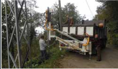
Trafik İşaret ve Levhaları Montaj Çalışmaları
