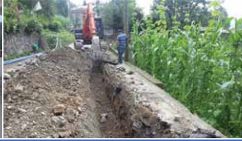
İçme Suyu Proje Çalışmaları
