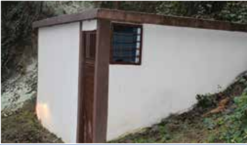
Depo Bakım ve Onarım Çalışmaları
