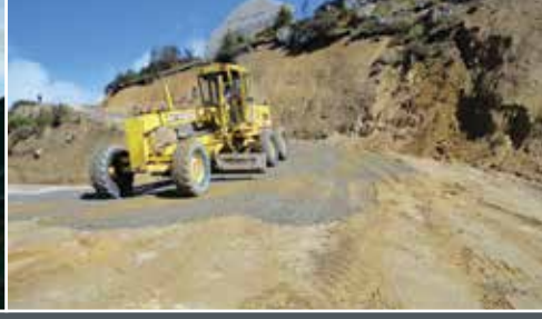
Bakım Onarım Çalışmaları
