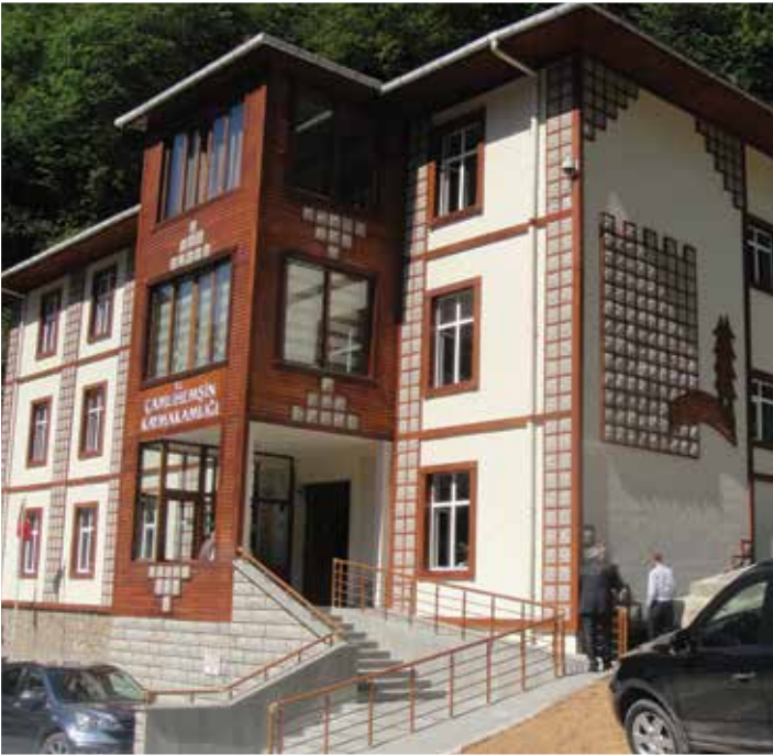
Çamlıhemşin Hükümet Konağı dış cephe uygulaması
