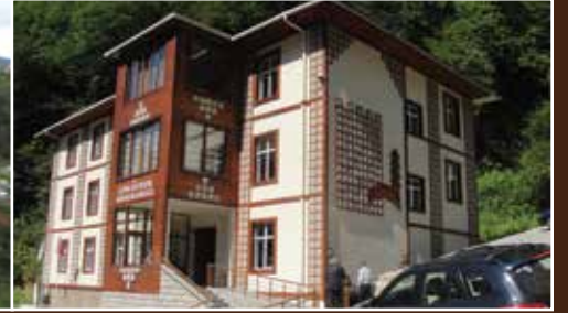
Çamlıhemşin Hükümet Konağı Onarımı
