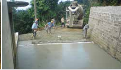
Beton Kaplama Çalışmaları
